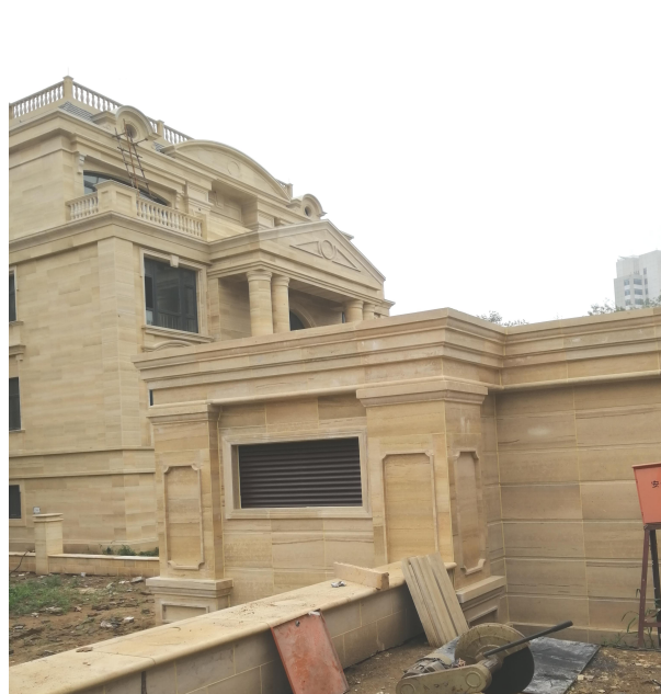
地下车库排风井
